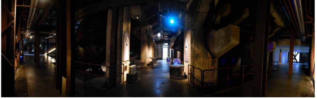
Şekil 6.37: 1 numaralı makine dairesi, zemin kat atmosfer imajı (B. Kaşlı arşivi).
