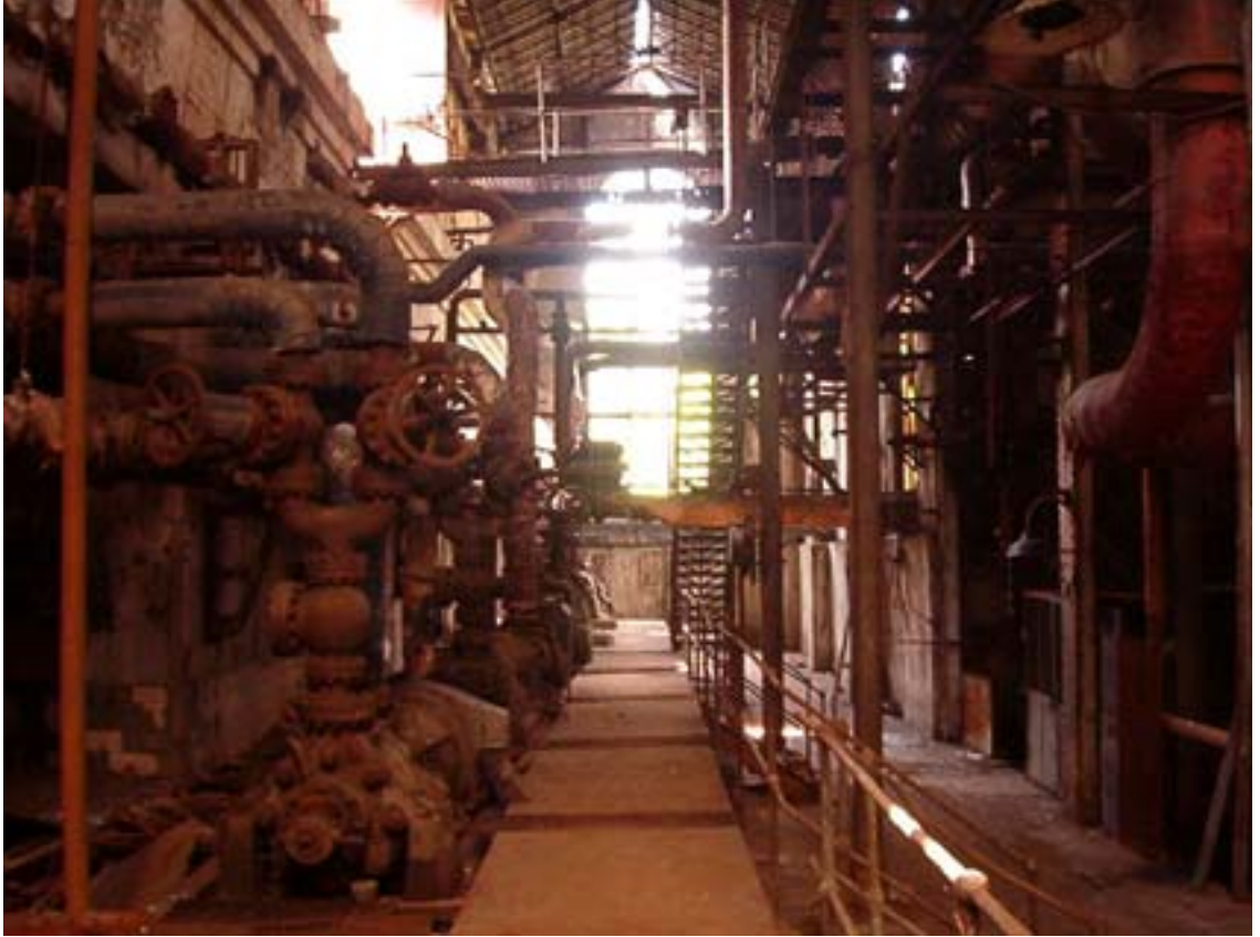
Şekil 6.14: 1 numaralı makine dairesi zemin kat, müdahale öncesi görünüm (DS Mimarlık arşivi).
