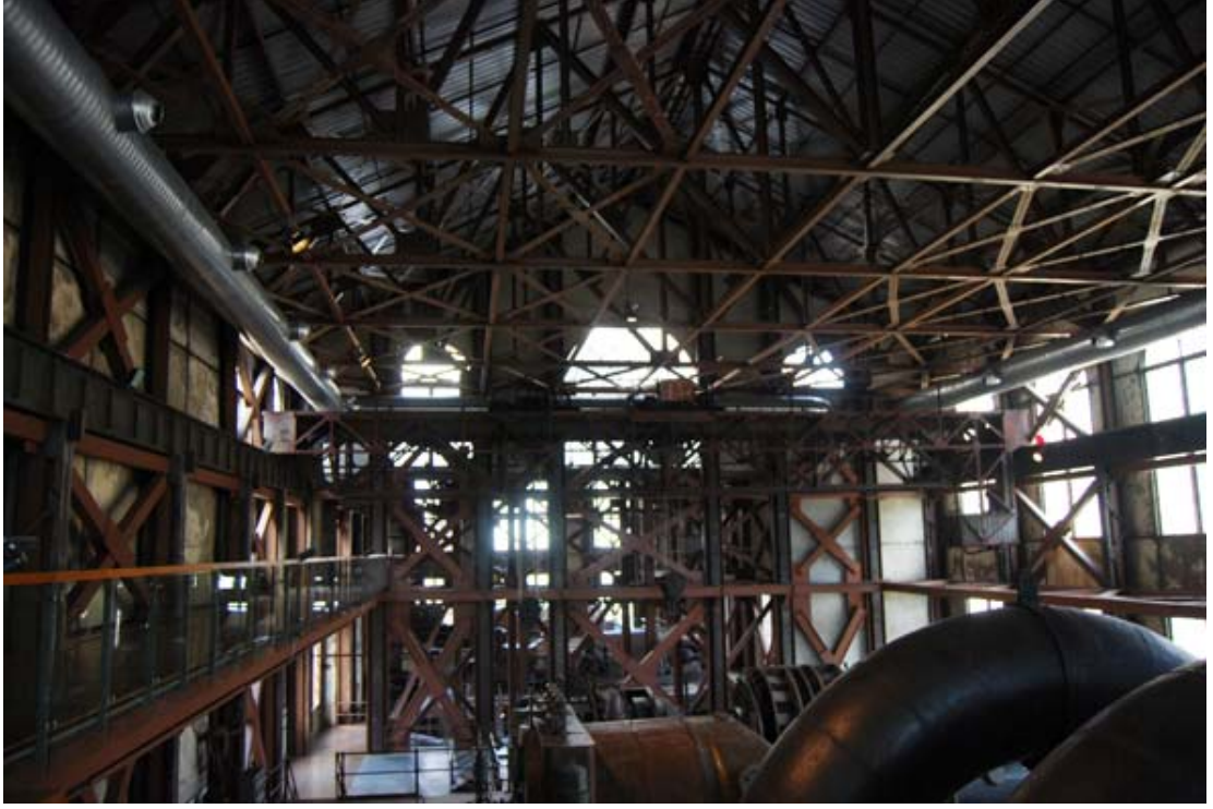
Şekil 6.21: 1 numaralı makine dairesi, müdahale sonrası çelik konstrüksiyon ve hacimsel algı (B. Kaşlı arşivi).
