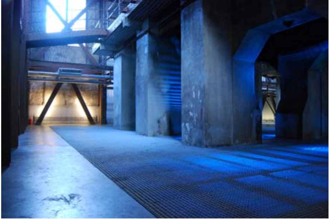
Şekil 6.15: 2 nolu makine dairesi, müdahale sonrası metal ızgara ve beton döşeme (B. Kaşlı arşivi).
