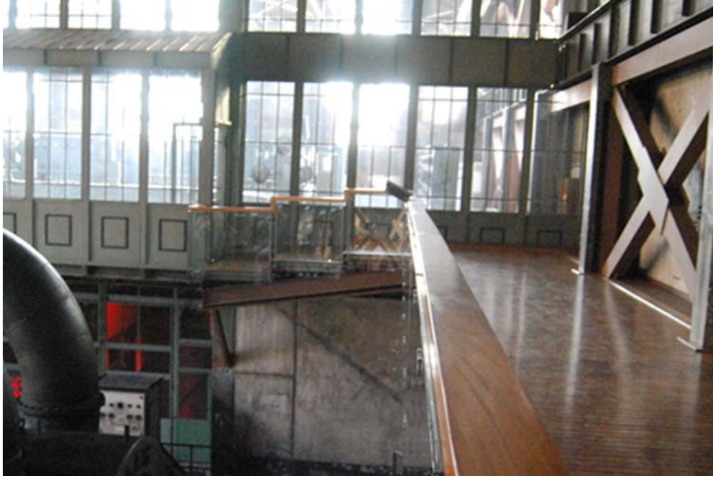
Şekil 6.31 : Müdahale sırasında kaldırılan merdivenin yerine konumlanan gezi iskelesi (B. Kaşlı arşivi).
