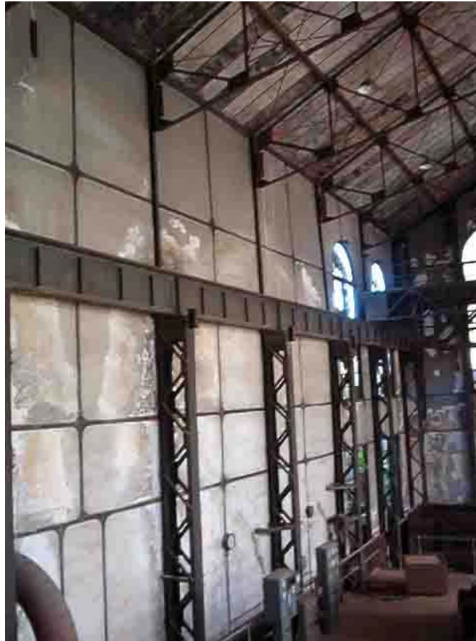
Şekil 6.20 : 1 numaralı makine dairesi, müdahale öncesi çelik konstrüksiyon (DS Mimarlık arşivi).
