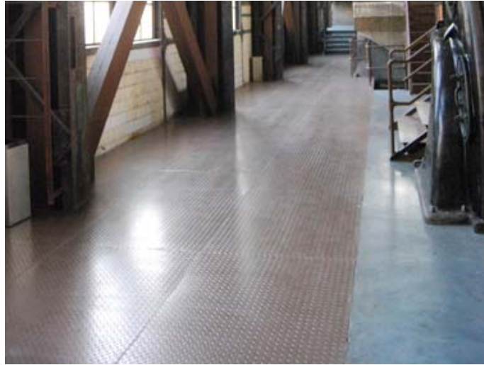
Şekil 6.17 : 1 numaralı makine dairesi türbin-jeneratör grupları etrafındaki yeniden yapılan döşeme (B. Kaşlı arşivi).
