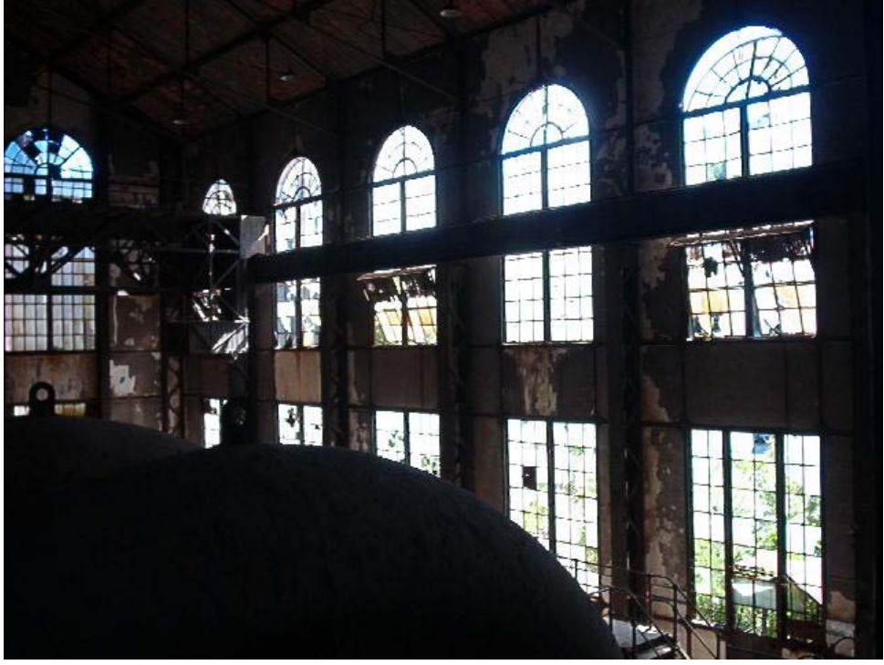
Şekil 6.32: 1 numaralı makine dairesi cephelerindeki iri pencereler, müdahale öncesi durum (DS Mimarlık arşivi).
