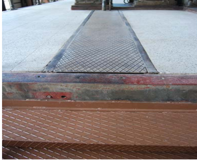
Şekil 6.16 : Döşemde kullanılan yeni ve eski metal malzeme (B. Kaşlı arşivi).
