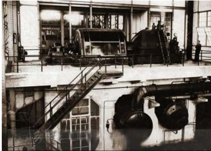
Şekil 6.6 : 2 numaralı makine dairesi içinde yer alan türbin- jeneratör grubu platformunun görüntüsü (www.santralistanbul.org).
