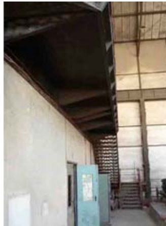
Şekil 6.30 : Müdahale sırasında kaldırılıp yerine gezi iskelesi bağlanan merdivenin müdahale öncesi görüntüsü (DS Mimarlık arşivi).
