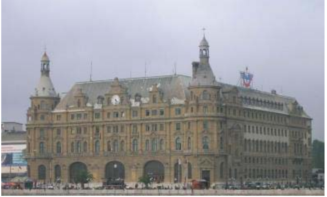
Şekil 2.5: Haydarpaşa Gar binası (www.demiryolu.tr.gg).
